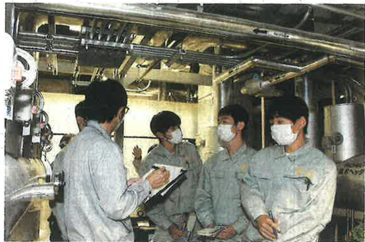
空調設備の機械室を見学する生徒たち ＝四日市市日永東1の市総合体育館で
