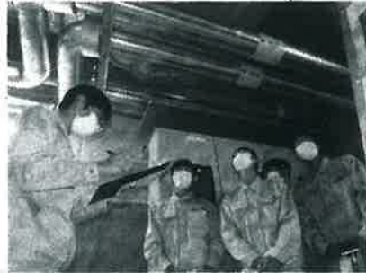
藤原工業の担当者(左)から空 調・給排水設備の説明を受ける 四中工生徒
